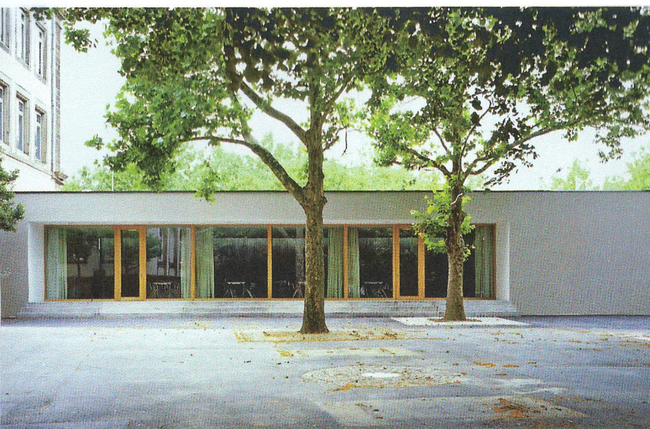
L'ampliamento ad un piano dalle forme lineari si apre sul cortile della scuola con una vetrata di grandi dimensioni.
