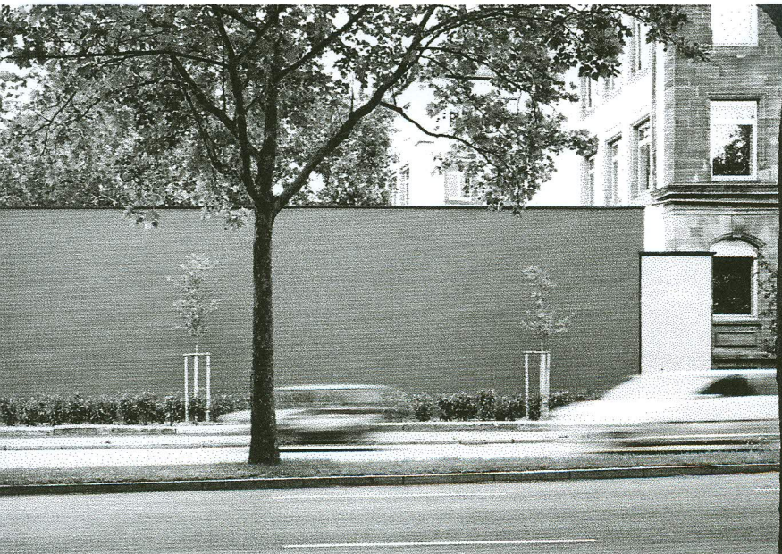
La parete posteriore sovrelevata del nuovo edificio ha la funzione di un muro di protezione dal rumore che proviene dalla strada a sud, fortemente trafficata.
