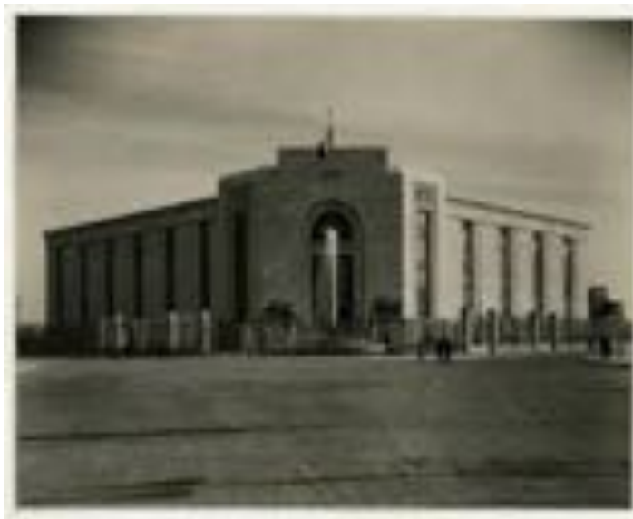
Centrale elettrica, Milano
